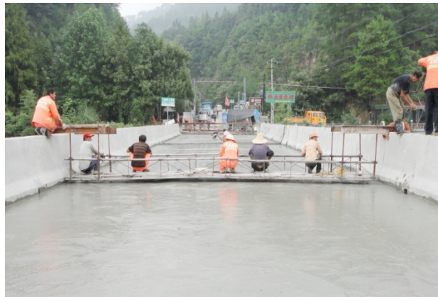
桥面铺装施工
