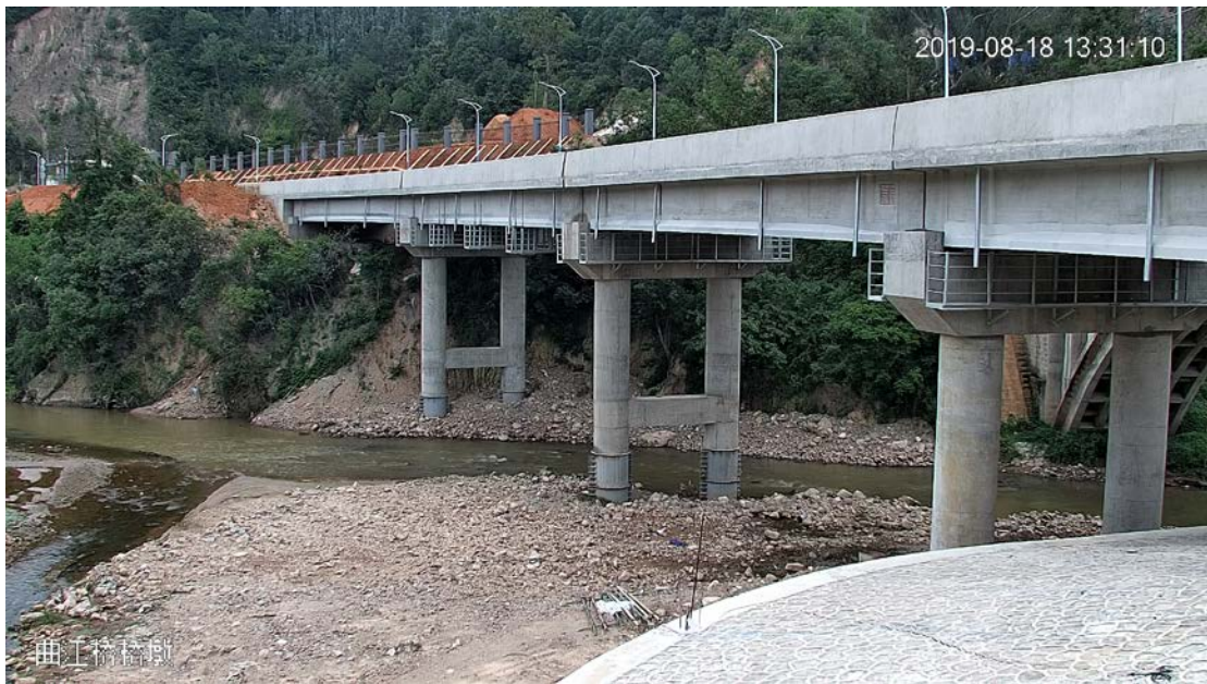
桥梁监测实况
